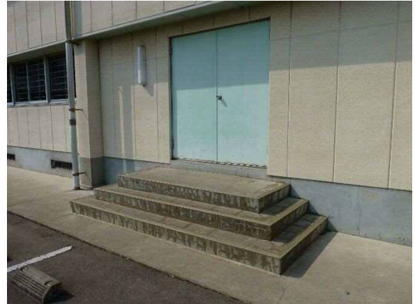
【建物南側の非常扉】
